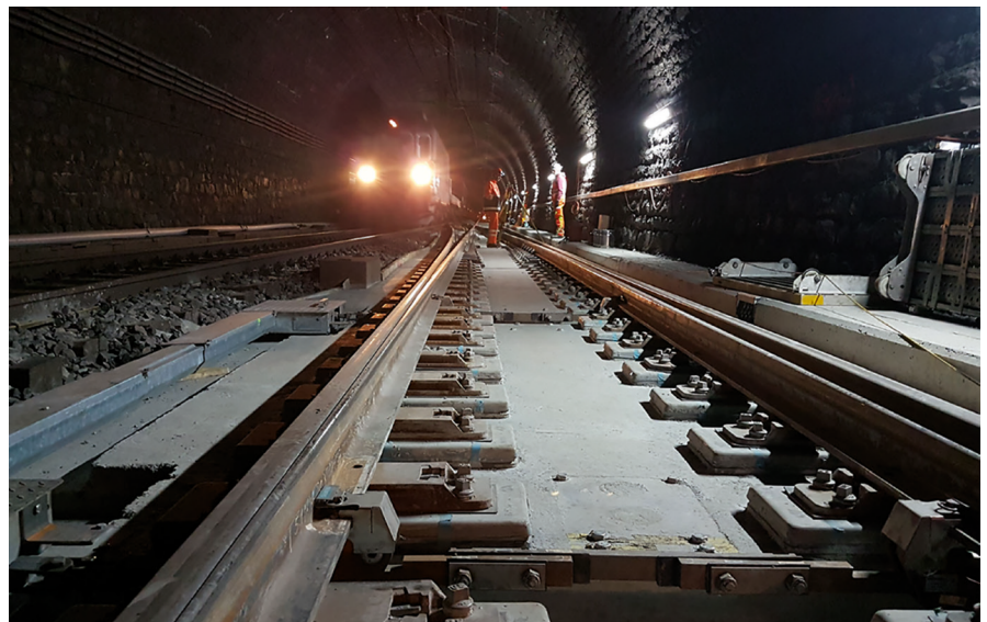
Das Schottertrassée wird durch eine Betonsohle ersetzt. Überbreite Züge würden die Sicherheit auf der Baustelle gefährden und müssen aufgehalten werden.
