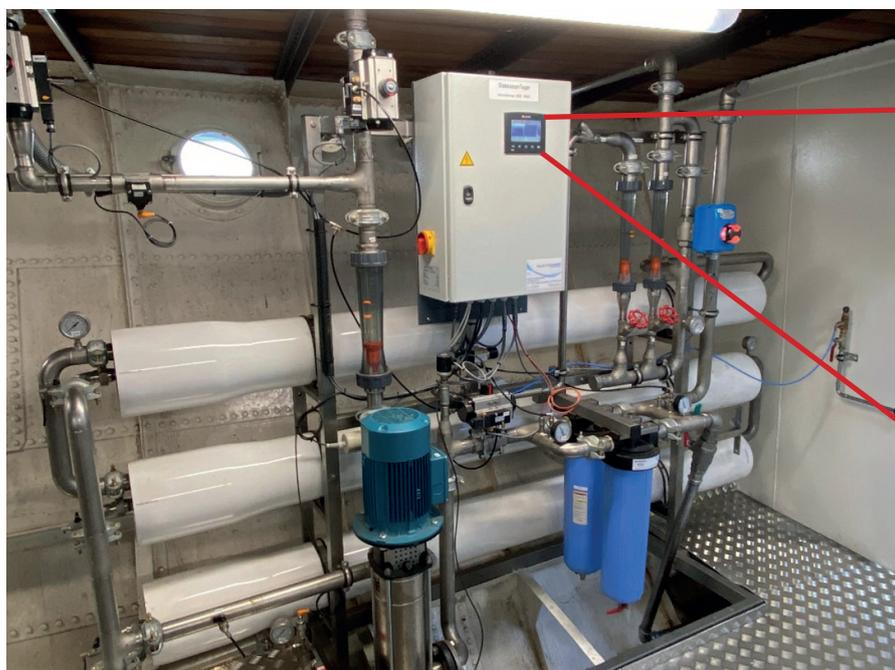
PLC V430 per il controllo dell'impianto di osmosi inversa per la produzione di acqua del «Stadt Rapperswil» della ZSG.
