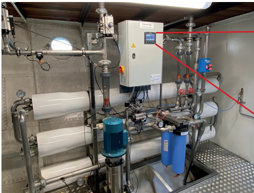
V430 SPS zur Steuerung der Umkehrosmoseanlage für die Dampferzeugung der «Stadt Rapperswil» der ZSG.
