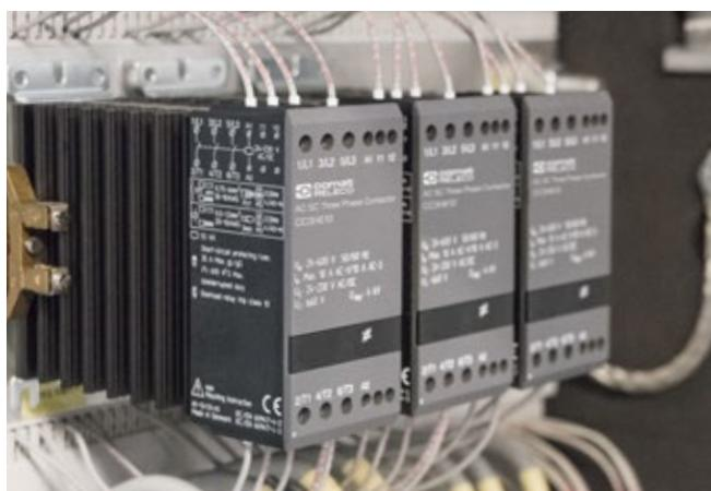
Die eingesetzten **CIM1R** Zeitrelais werden zur Beleuchtungssteuerung im Fahrerstand des Zuges verwendet. Das Licht schaltet nach einer bestimmten Zeit aus oder kann durch Betätigung eines Tasters vor Abfahrt des Zuges manuell ausgeschaltet werden.
