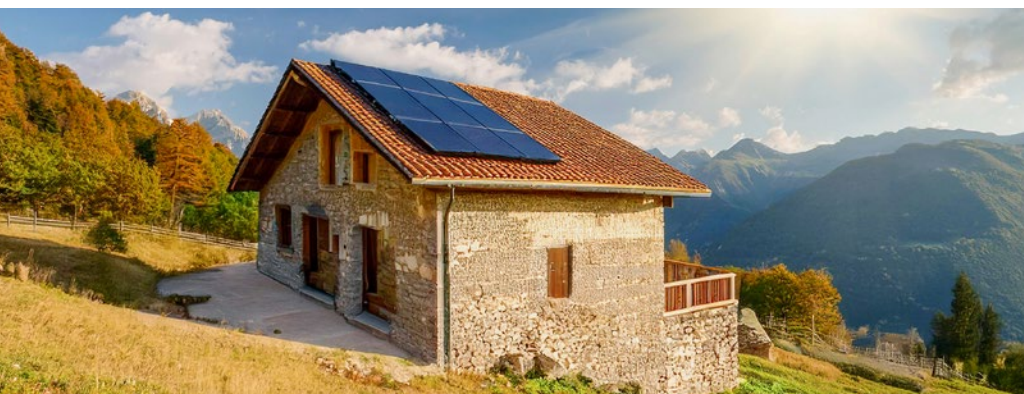
■ Une installation photovoltaïque alimente de manière autonome cette maison située dans les montagnes italiennes. Le système de surveillance est piloté à distance à 800 kilomètres de là.
